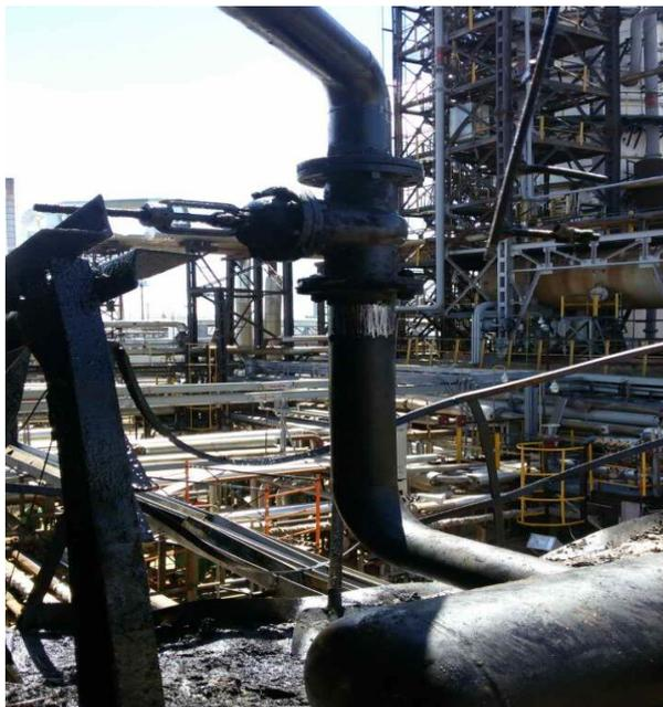
Рисунок 7 – Реализация события разгерметизации линии трубопровода с нефтью
