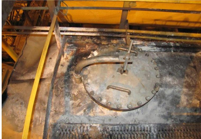
Рисунок 5 – Реализация события разгерметизации емкости с теплоносителем (керосин)
