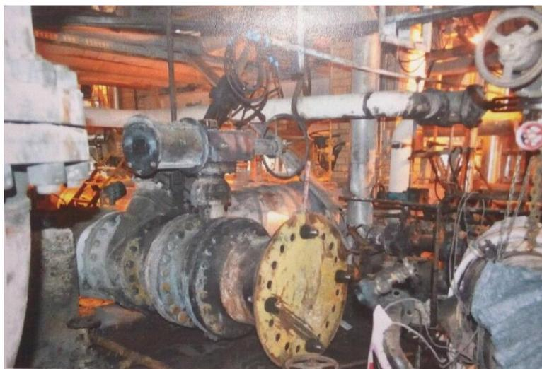
Рисунок 8 – Последствия пожара в насосной вакуумного блока установки первичной переработки нефти
