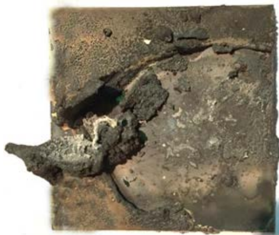
Рисунок 25 – Разрушение огнезащитного покрытия Фризол-ЭП после окончания проведения испытаний при температуре 1100 °С
