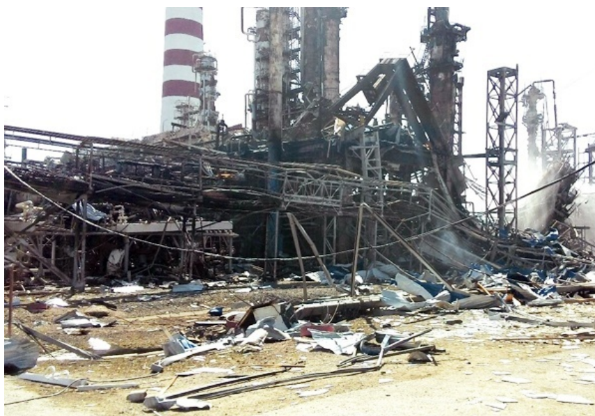
Рисунок 2 – Разрушение конструкций в результате аварии на Ачинском НПЗ в июне, 2014 года
