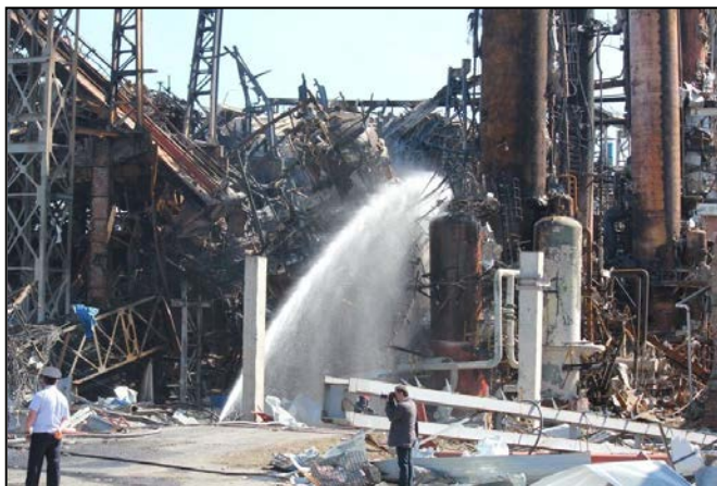
Рисунок 10 – Разрушение строительных конструкций при пожаре на Ачинском НПЗ, июнь 2014 г.
